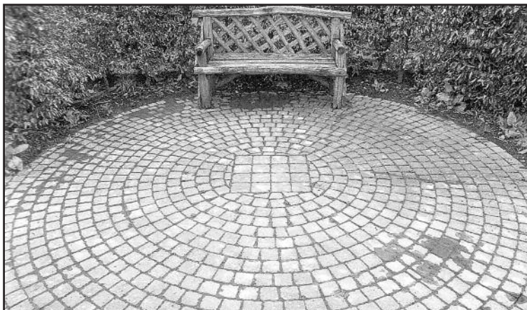
Kamen za popločavanje. Malter za temelje i spojeve popločanih delova bašte može da se pravi s krečom umesto cementa.
